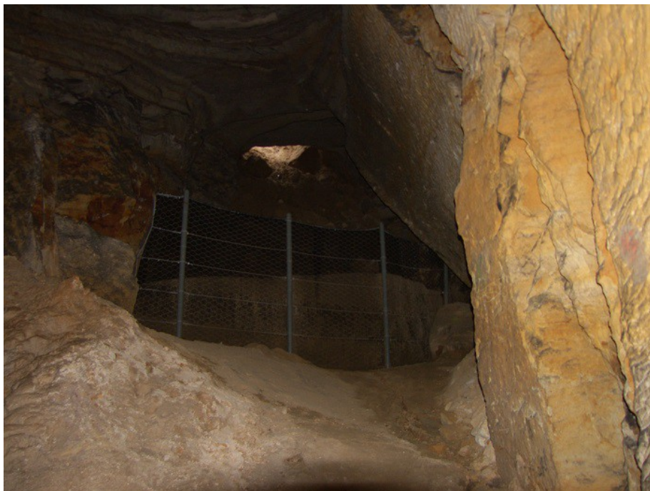
Obr. 7 – Závál ve vstupní části důlního díla byl zajištěn v roce 2012 pomocí záchytného vysokopevnostního plotu. Na snímku je dále patrný propad v úrovni čelní stěny lomu, který byl zabezpečen v roce 2016 (Foto: Z. Vitáček).
