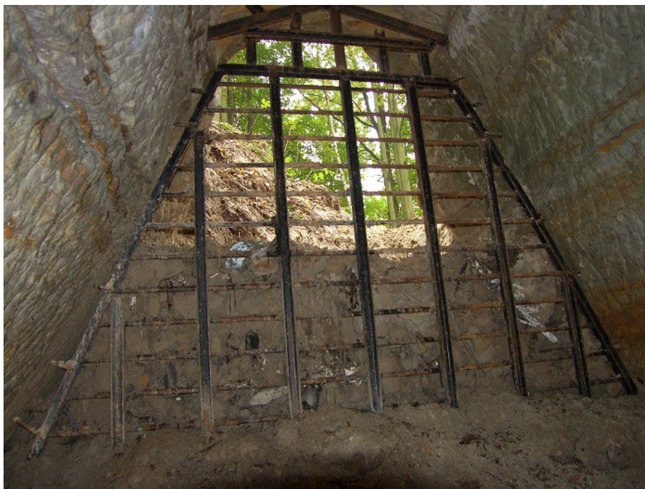
Obr. 7 – Závál ve vstupní části důlního díla byl zajištěn v roce 2012 pomocí záchytného vysokopevnostního plotu. Na snímku je dále patrný propad v úrovni čelní stěny lomu, který byl zabezpečen v roce 2016 (Foto: Z. Vitáček).
