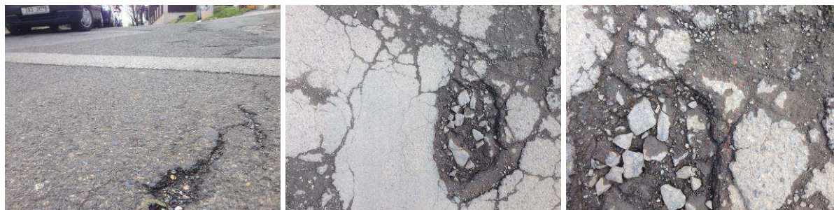
Obr. 6.17.: Silně poškozený povrch
