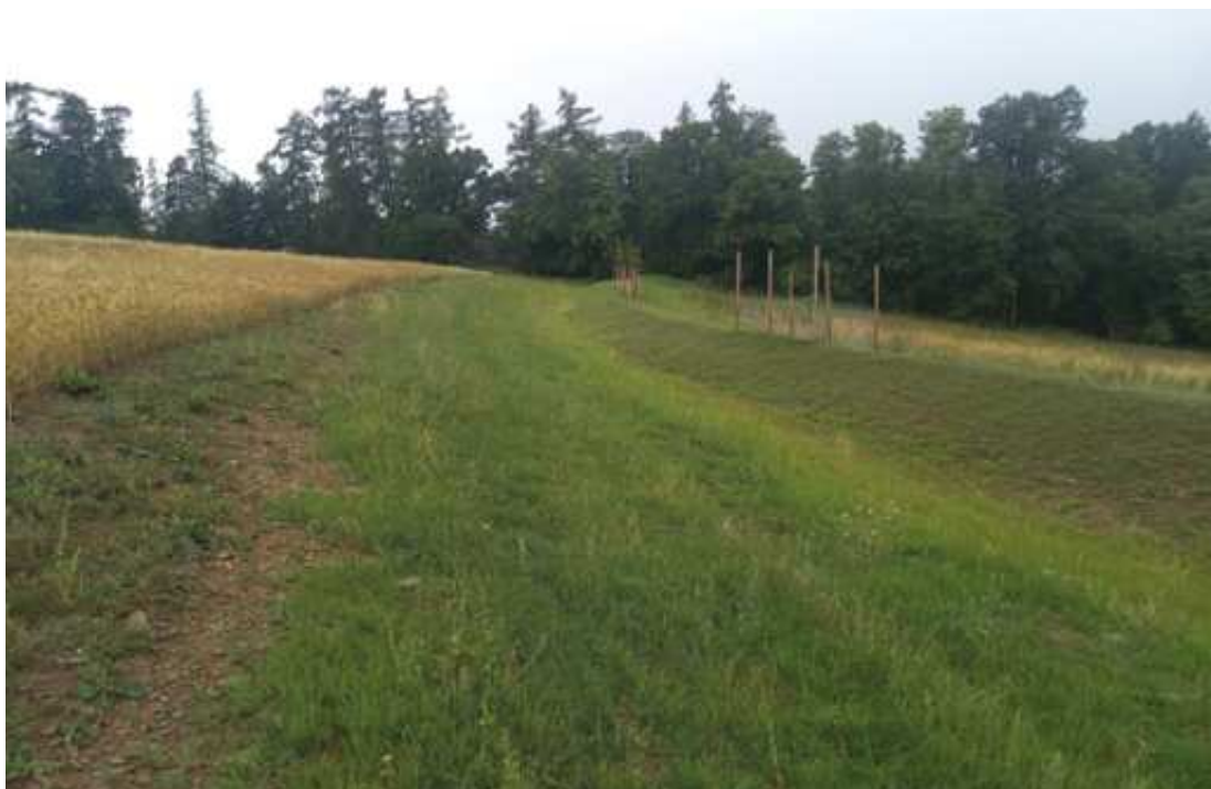
Obr. 1-27. Záchytný průlehy s funkcí odváděcí se zemní hrázkou a ozeleněním
