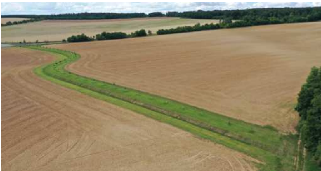
Obr. 1-30. Záchytný příkop s funkcí odváděcí bez zemní hrázky, se zasakovacím travním pásem a vegetačním doprovodem
