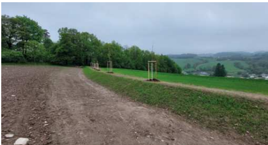
Obr. 1-37. Protierozní hrázka se záchytnou a usakovací funkcí
