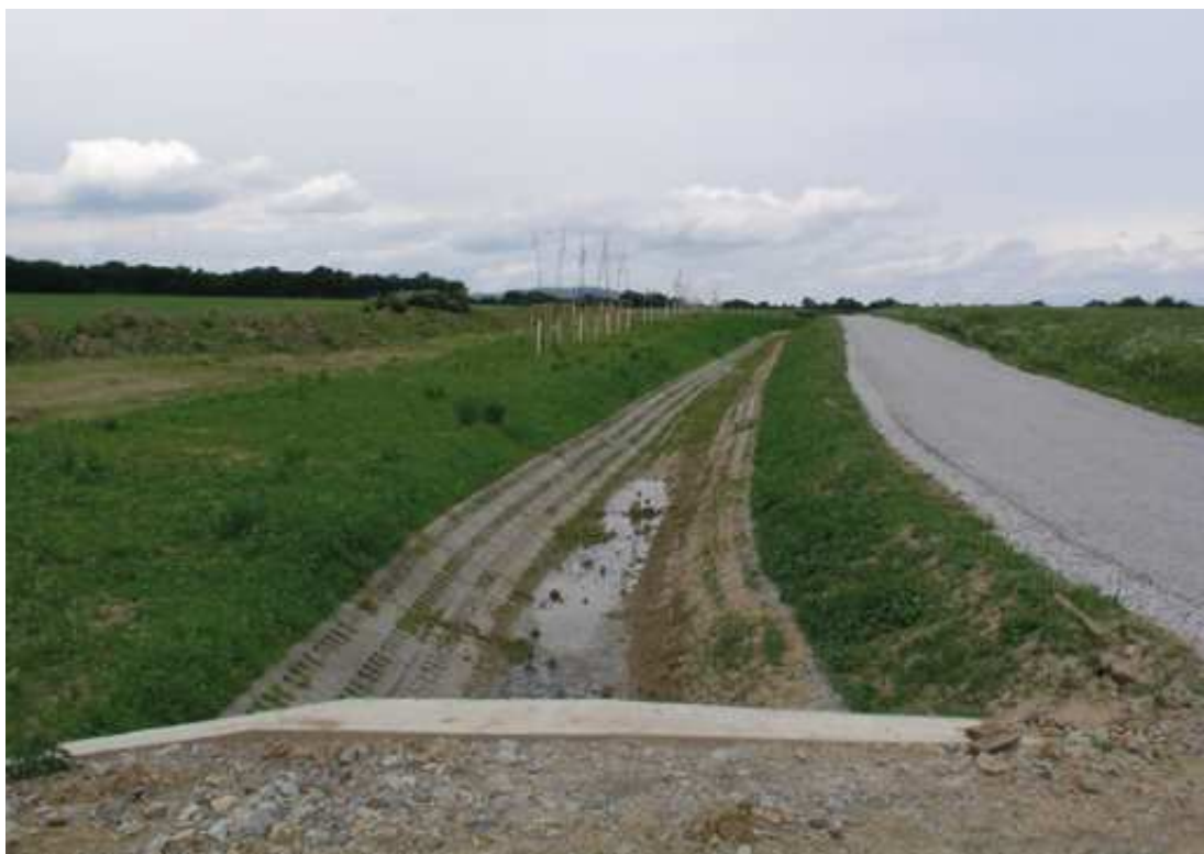
Obr. 1-47. Zpevnění svodného příkopu - polovegetační tvárnice
