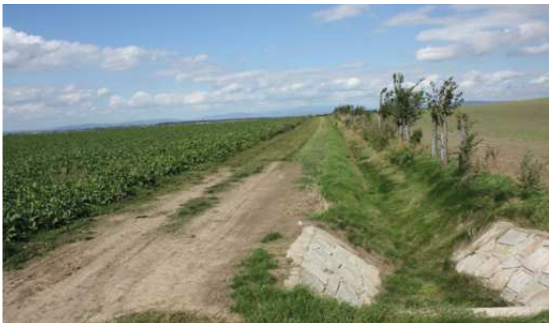
Obr. 1-39. Polní cesta s protierozní funkcí s příkopem a s vegetačním doprovodem
