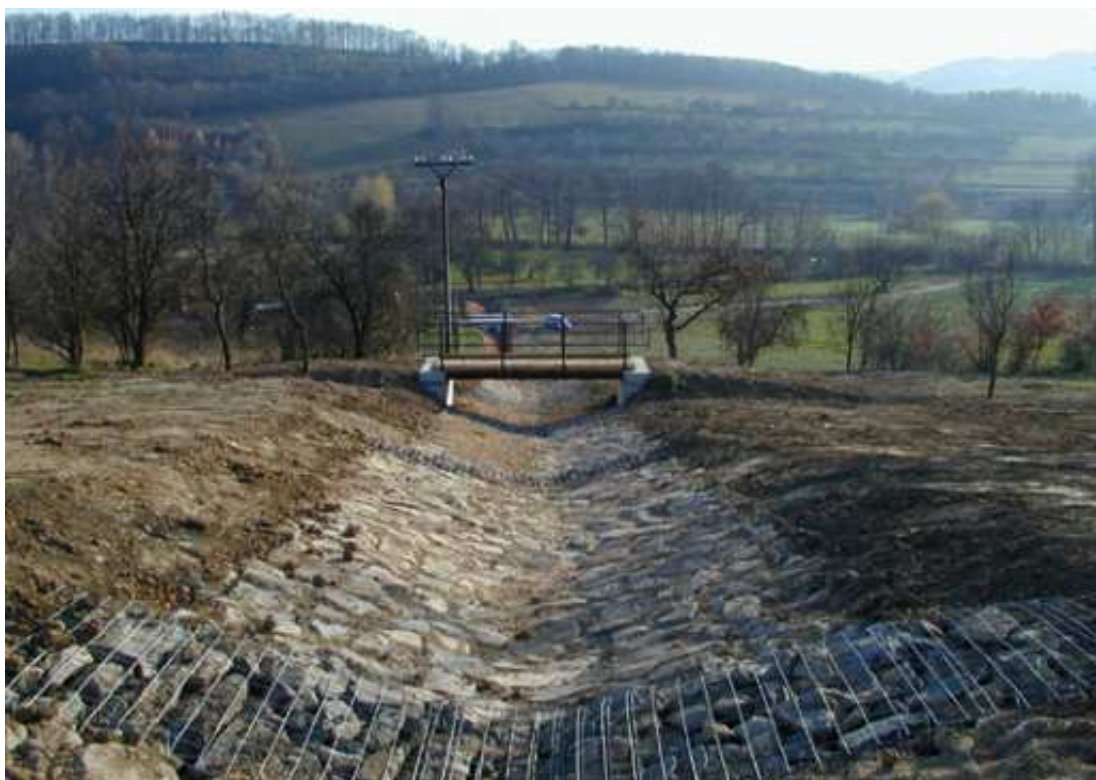
Obr. 1-49. Zpevnění svodného příkopu - kamenný pohoz, drátokamenné přehrážky
